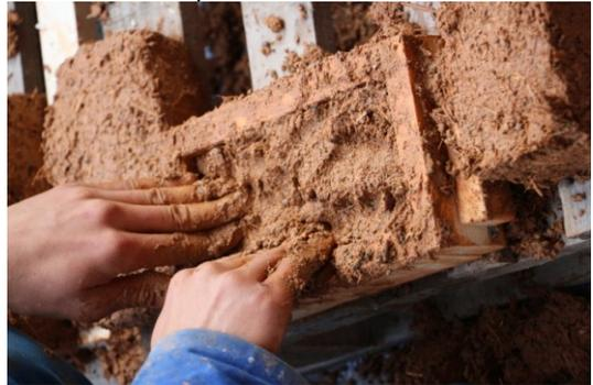
Une fois les fondations achevées, un coffrage a été confectionné afin d'accueillir la partie en pisé (mélange de terre argileuse et sable compressé, à l'aide d'un pisoir ou « pisou »). Les élèves ont alors renversé des seaux de pisé puis entassé les couches successives avec les pisoirs.
