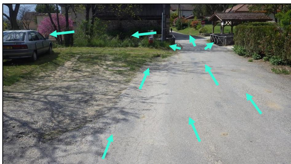
A noter que en amont immédiat du carrefour avec la route de la Bascule, 3 merlons (petit dos d'âne) ont été réalisés en travers de la voirie afin d'intercepter les eaux ruisselées et les rediriger vers le cours d'eau. Les travaux étant récents, leur efficacité n'a pu être testée. On remarquera des risques de déstabilisation du mur en rive droite du ruisseau au droit de ces Merlon.
