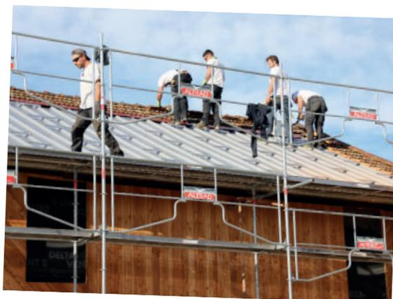
Nous voici en février 2022, et vous avez peut-être assisté aux travaux. Les tuiles (vieilles du plus de 80 ans) sont remplacées par une structure métallique sur laquelle reposent les panneaux photovoltaïques. Le Consuel (organisme de contrôle) est passé il y a quelques jours : l'installation électrique est déclarée conforme. La dernière étape consiste à raccorder les panneaux au réseau électrique : cette opération sera traitée prochainement par ENEDIS.
